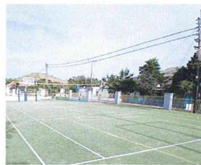
Εικόνα 21: Η νότια πλευρά του γηπέδου, χωρίς φύτευση και τα εναέρια καλώδια ΔΕΗ
