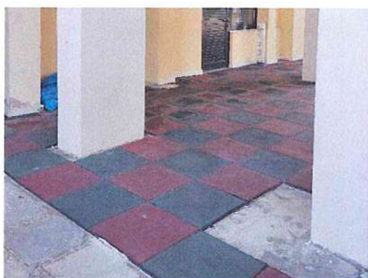
Εικόνα 7: Φθορά πλακιδίων ασφαλείας
