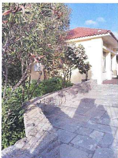
Εικόνα 4: Τοίχιο από λιθοδομή στο β/δ παρτέρι
