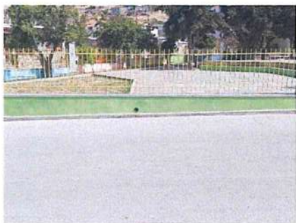
Εικόνα 19: Οπές αποστράγγισης υδάτων στο νότιο τοιχίο του σχολείου
