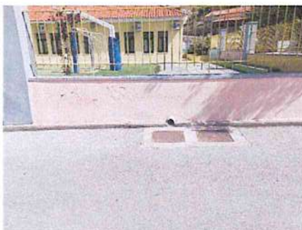
Εικόνα 20: Οπές αποστράγγισης υδάτων στο νότιο τοιχίο του σχολείου
