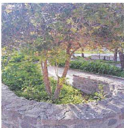
Εικόνα 13: Τοίχιο από λιθοδομή και διαμόρφωση παρτεριού
